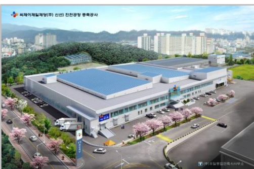
진천 육가공 공장
