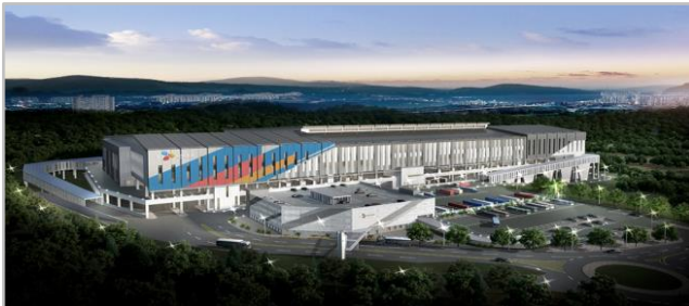
택배 수도권 Mega HUB 터미널(294,350 m 2 )
