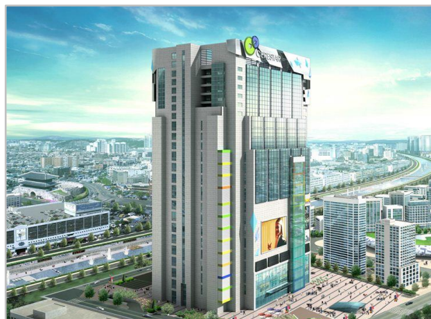
동대문 현대시티아울렛 리모델링 (호텔+상업 123,847 m 2 ) [운영사 : 스카�팍크]
